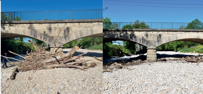
Démontage d'embâcle à Saint-Maurice-de-Rémens, avant/après
