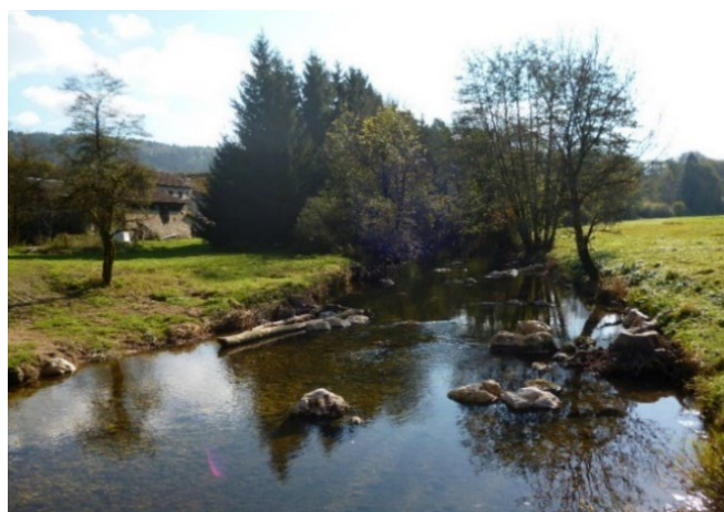
Exemple de mise en place d'éléments de rugosité sur l'Oignin à St Martin du Frêne
