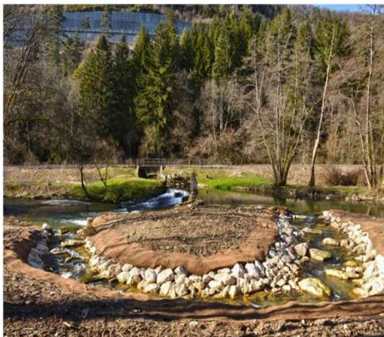
Chenal de contournement sur le Lange à la Tournerie (Montréal)
