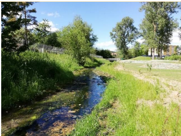
Exemple de lits emboîtés sur la Sarsouille à Oyonnax
