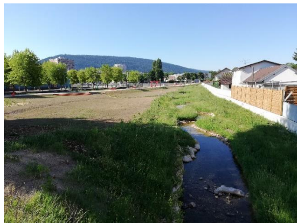
Exemple de lits emboîtés – la Sarsouille à Oyonnax
