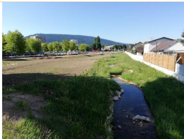
Exemple de lits emboîtés sur la Sarsouille à Oyonnax
