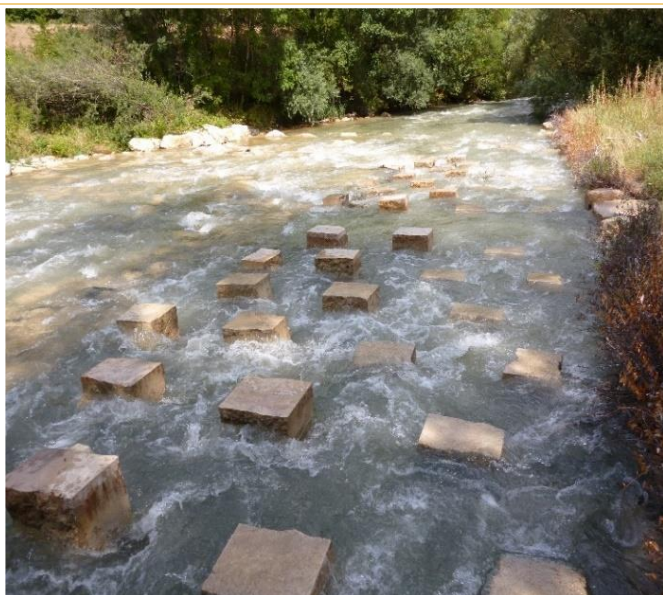
Passe à poissons sur l'Oignin à St Martin du Frêne
