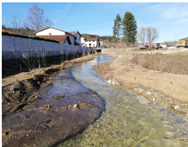
Renaturation de la Sarsouille à Oyonnax
