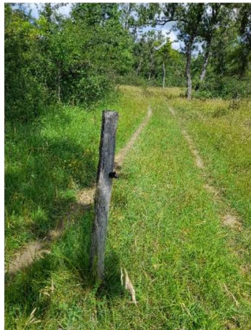
Une clôture électrique 1 rang fixe (piquet bois) posée en 2014 borde les parties Sud et Nord de l'unité. Un entretien irrégulier a entraîné sa détérioration et son mauvais état (Photo 7). Ajouté à cela, les broussailles l'envahissent et plusieurs piquets sont manquants. Le côté Ouest est cerné par les berges relativement abruptes de la rivière de l'Ain et dissuade le passage de tout type de troupeau.
