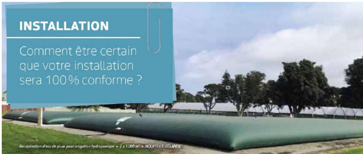
Récupération d'eau de pluie pour irrigation hydroponique • 2 x 1000 m<sup>3</sup> • NOUVELLE-ZÉLANDE
