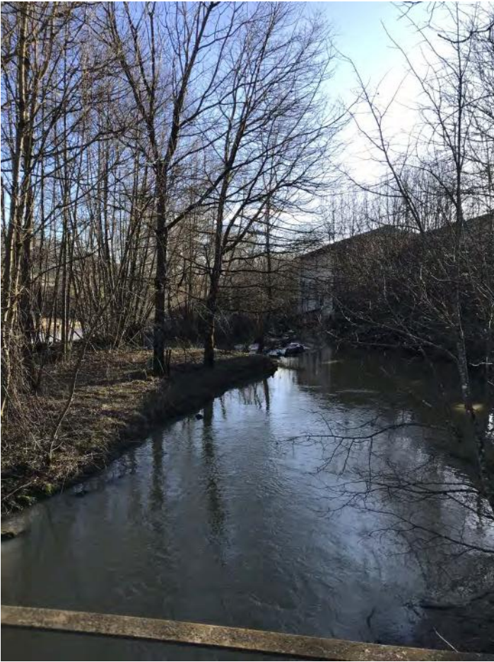
Seuil de Chavuiissiat (réserve incendie, absence d'entretien de l'ouvrage, parcours de pêche no-kill)
