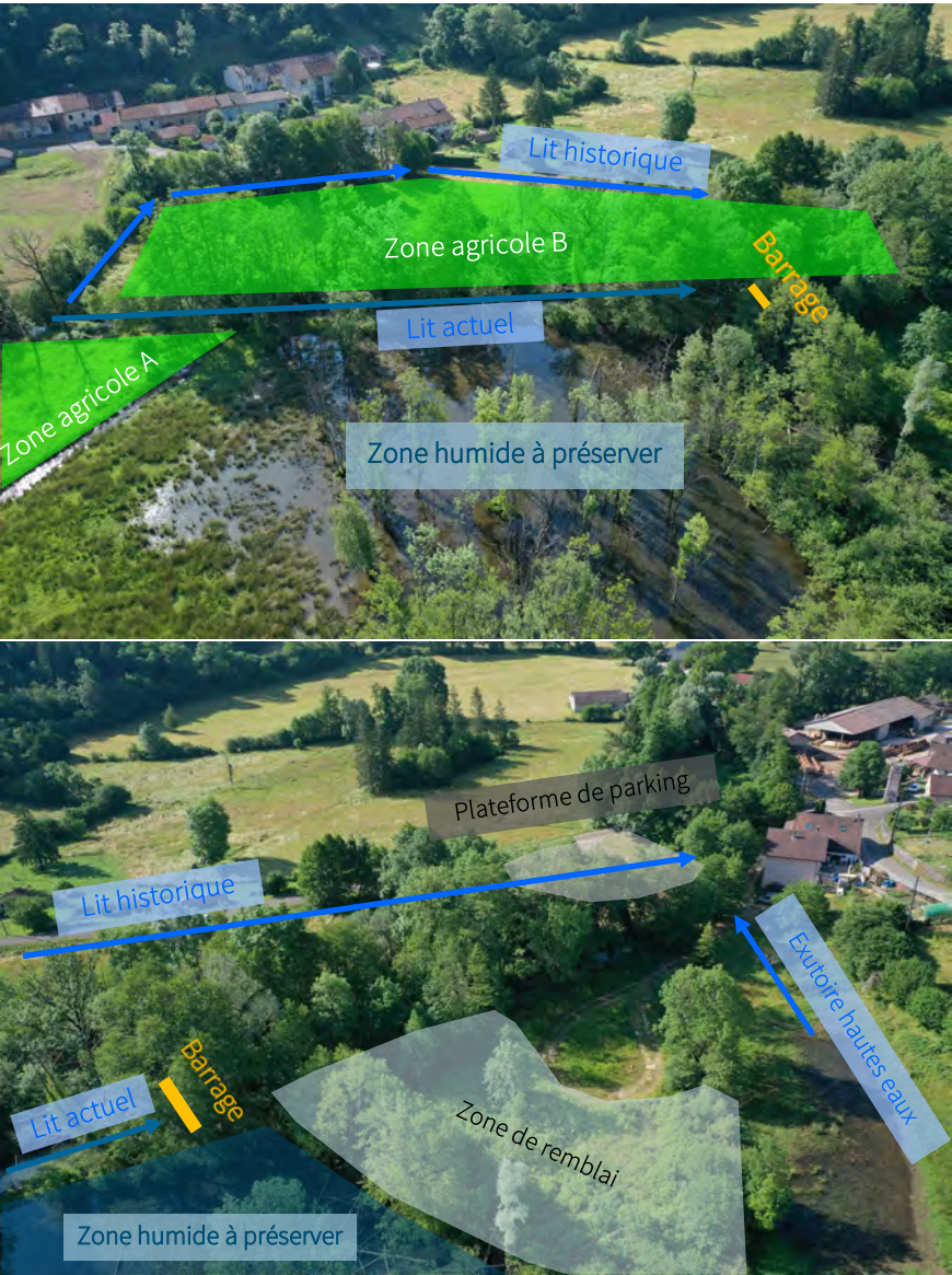
Vue de la zone de projet
