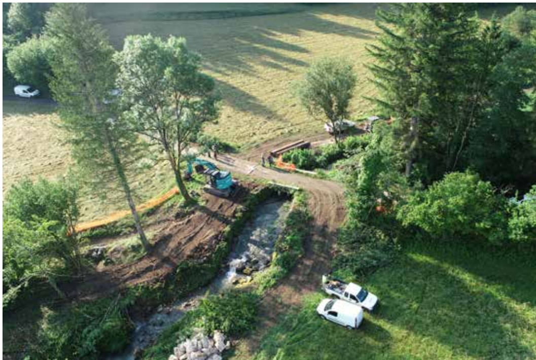
Restauration de l'Anconnans
