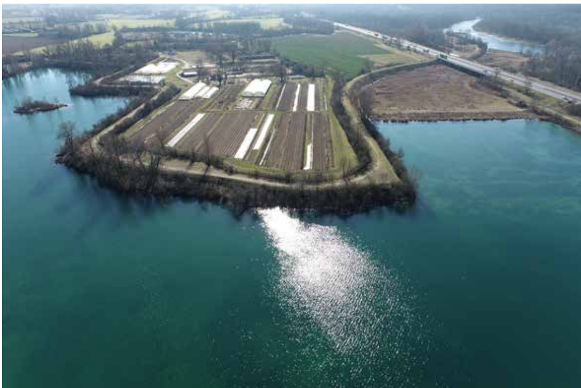
Système d'endiguement de Morette à Pont-d'Ain
