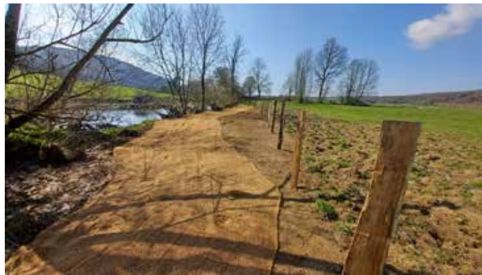
Plantation d'une clôture à Nivigne-et-Suran
