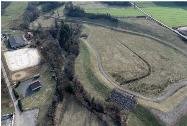
Aménagement hydraulique de Maillat à Brion
