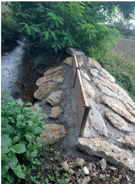
Confortement de berges réalisé en 2025 suite à la crue d'octobre 2024
