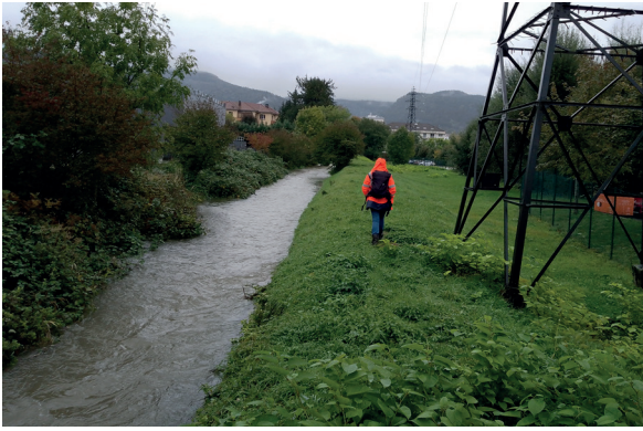
Visite semestrielle sur la digue de la Sarsouille à Oyonnax
