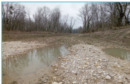
Chenal d'expansion de crue (Varambon)
