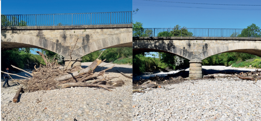
Démontage d'embâcle à Saint-Maurice-de-Rémens, avant/après
